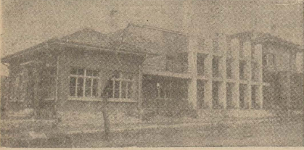
Sındırgı Parti ve Halkevi binası
